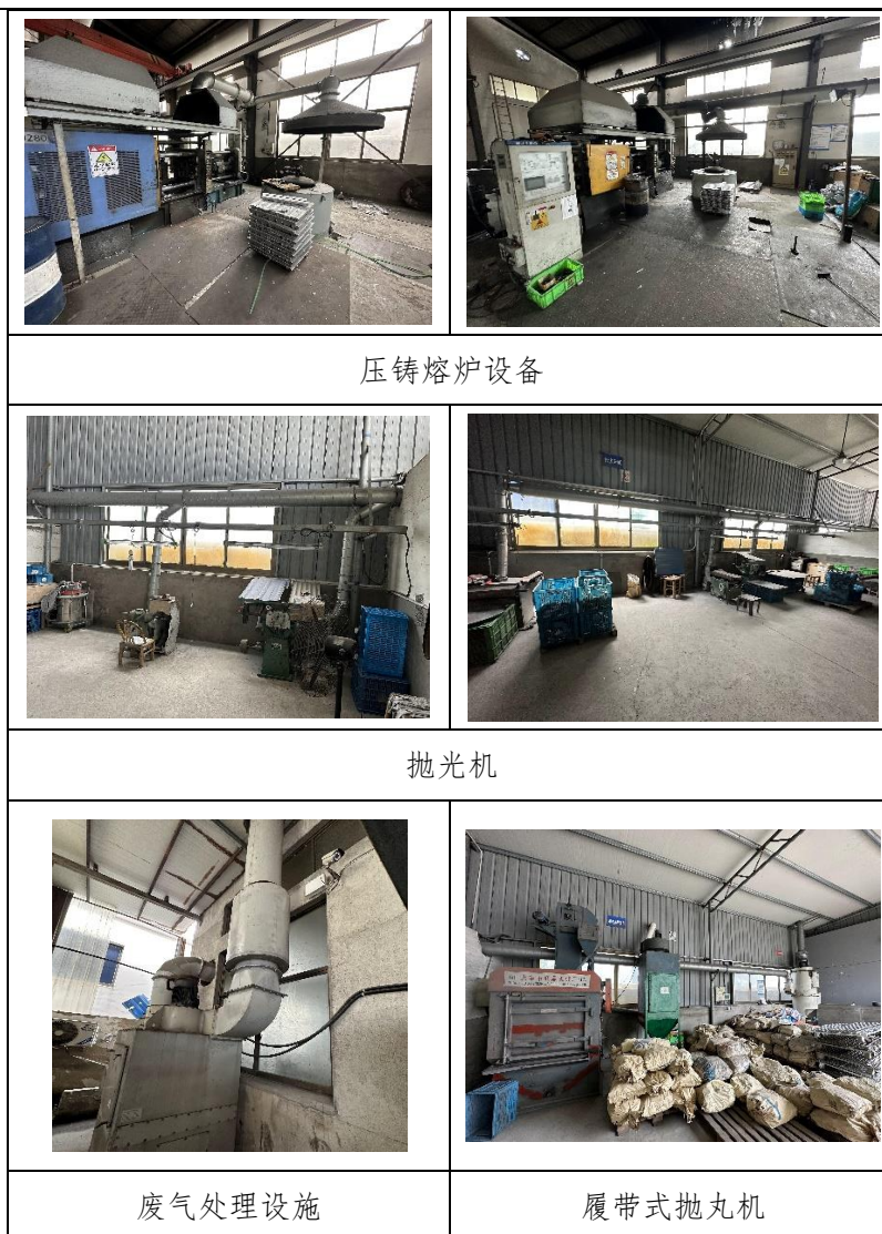
图 3-3 现场设备投产情况
